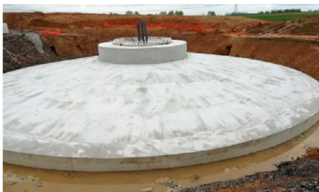
Figure 47: disque de fondation d'une éolienne terrestre
